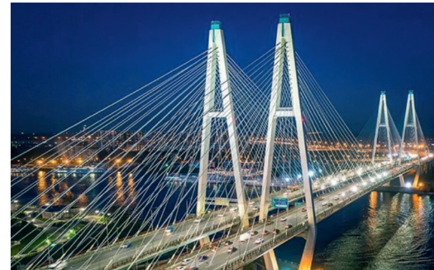
Большой Обуховский мост через р. Неву в г. Санкт-Петербурге, 2008 г.
