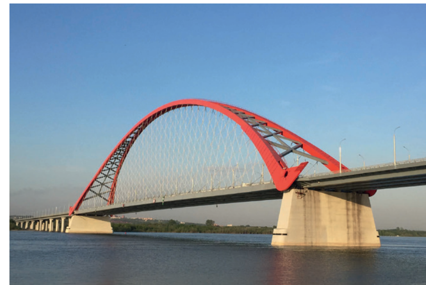
Бугринский мост через р. Обь в г. Новосибирске, 2014 г.
