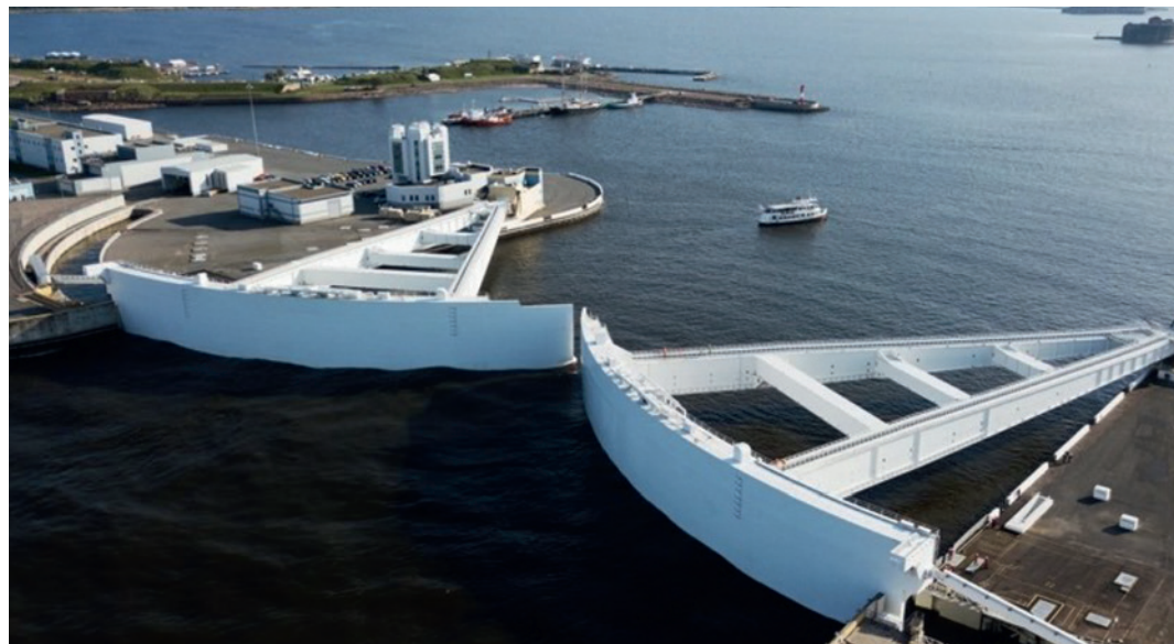
Судопропускное сооружение С-1 в составе КЗС, 2011 г.
