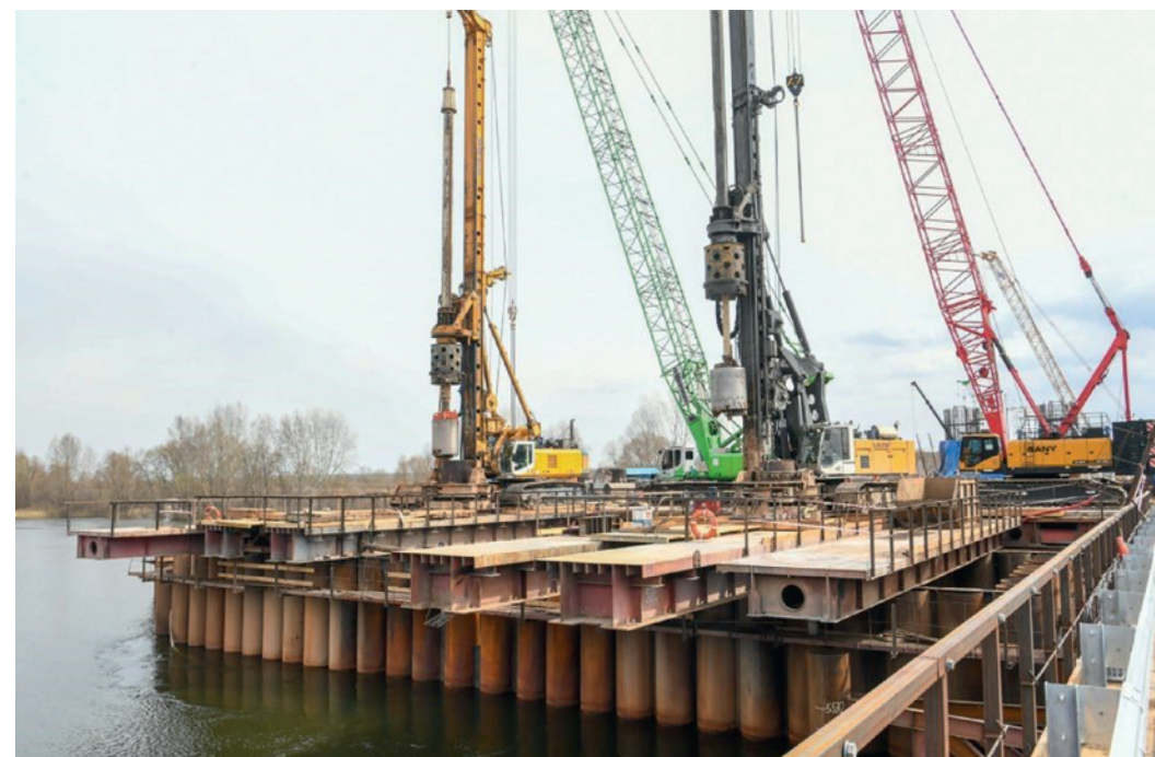
Монтаж пролетного строения моста через р. Каму, 2023 г.
