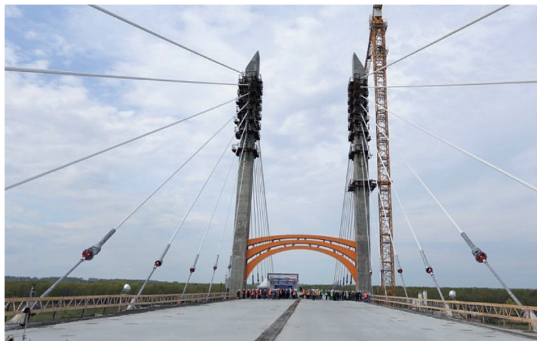
Замыкание центрального пролета вантового моста через р. Оку, 2023 г.
